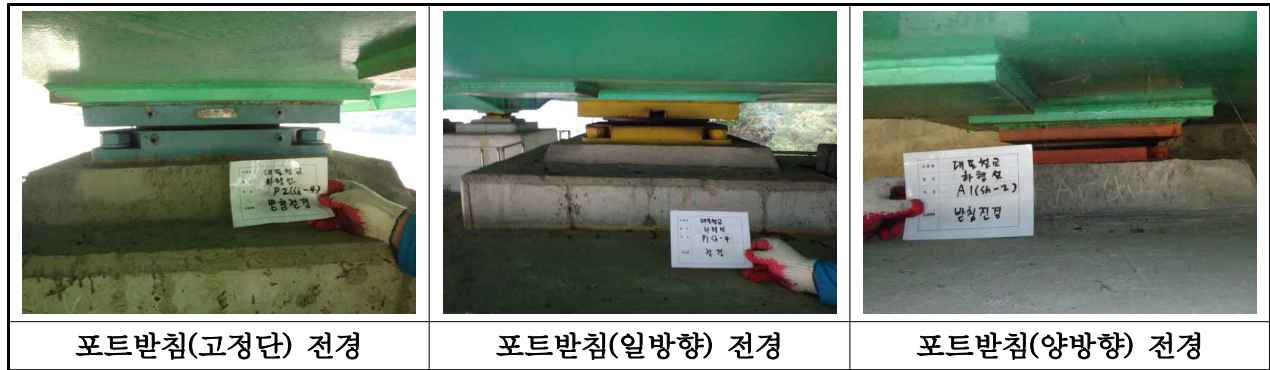
【사진 3.3.12】 교량받침 전경(부산)
