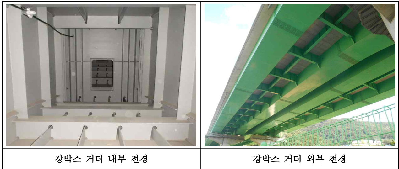
【사진 3.2.3】 강박스 거더 전경(대구)
