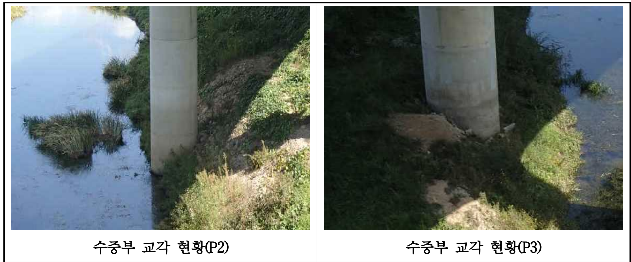
【사진 3.2.11】 교각 수중부 조사 현황(대구, 계속)
