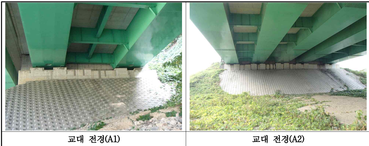
【사진 3.3.7】 교대 전경(부산)
