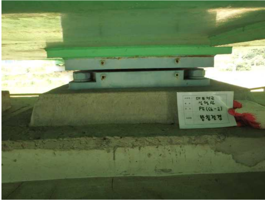
받침장치 전경 (고정단)
