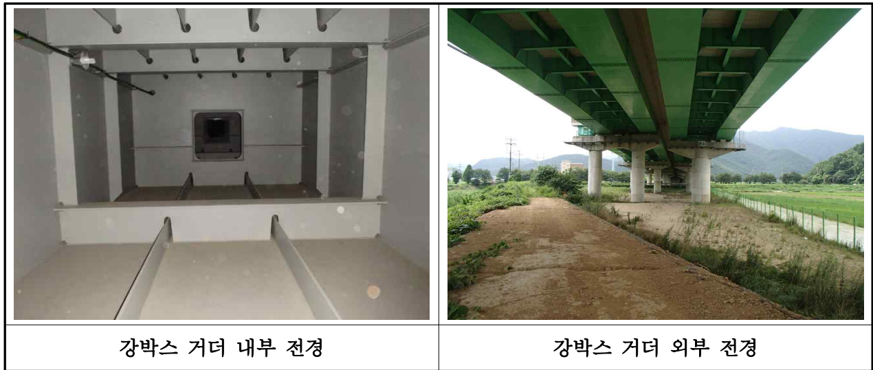
【사진 3.3.3】 강박스 거더 전경(부산)
