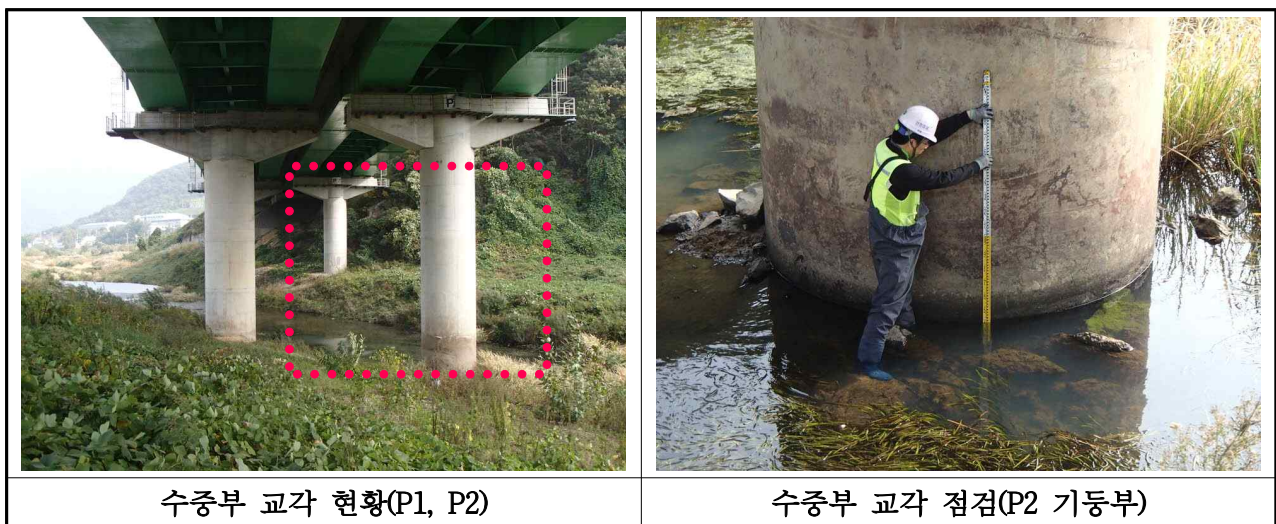
【사진 3.3.11】 교각 수중부 조사 현황(부산)
