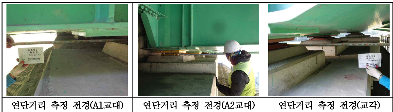
【사진 3.3.14】 연단거리 측정 전경(부산)
