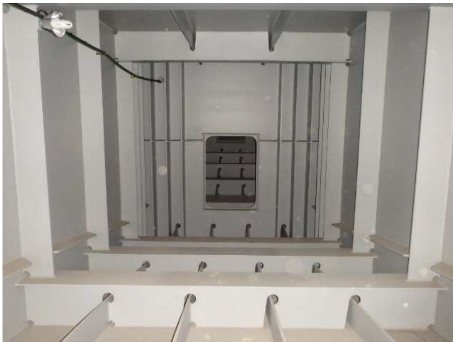
Steel Box Girder 내부 전경
