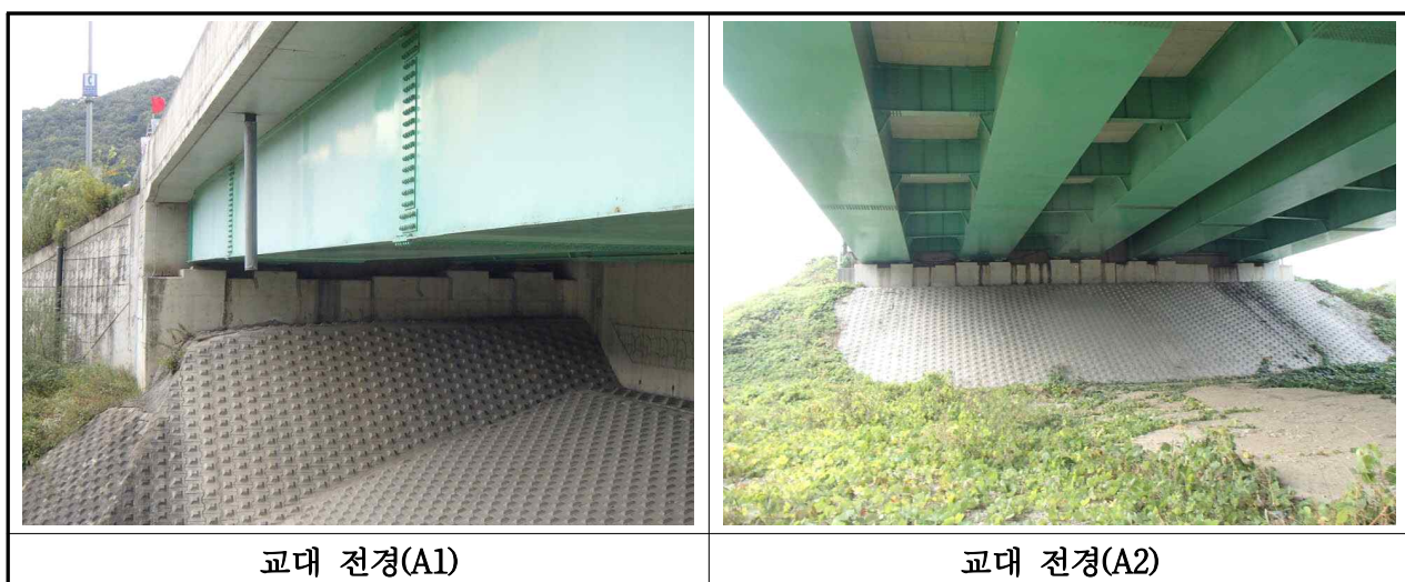
【사진 3.2.7】 교대 전경(대구)
