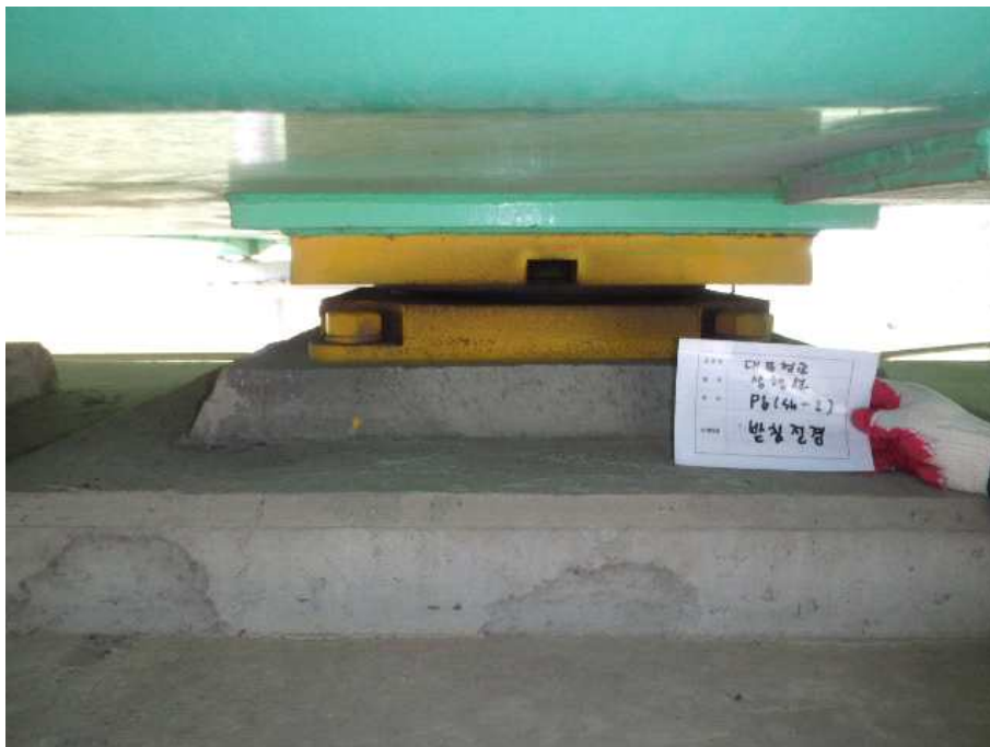
받침장치 전경 (가동단)
