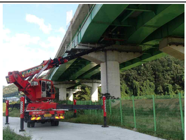
고소점검차를 이용한 조사
