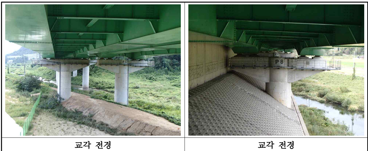
【사진 3.2.9】 교각 전경(대구)
