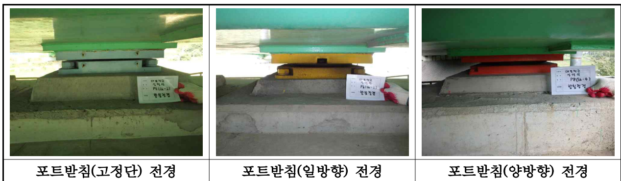
【사진 3.2.12】 교량받침 전경(대구)
