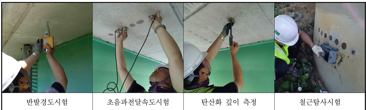
【사진 3.4.1】콘크리트 내구성조사 전경
