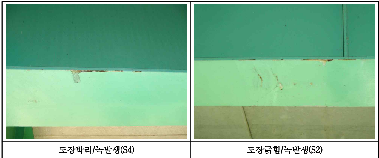
【사진 3.3.6】 가로보 및 세로보 전경(부산)
