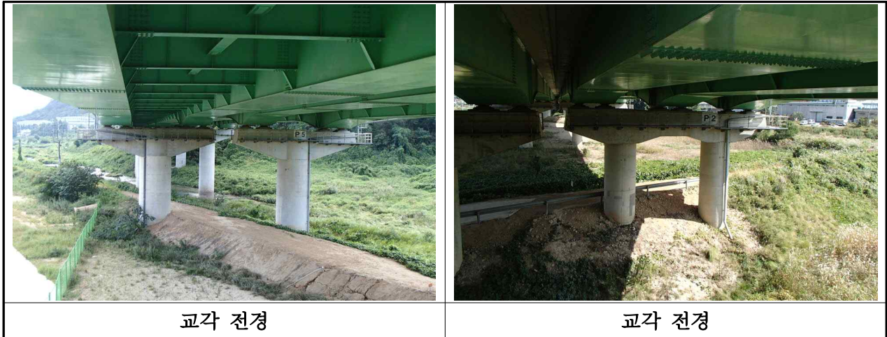
【사진 3.3.9】 교각 전경(부산)
