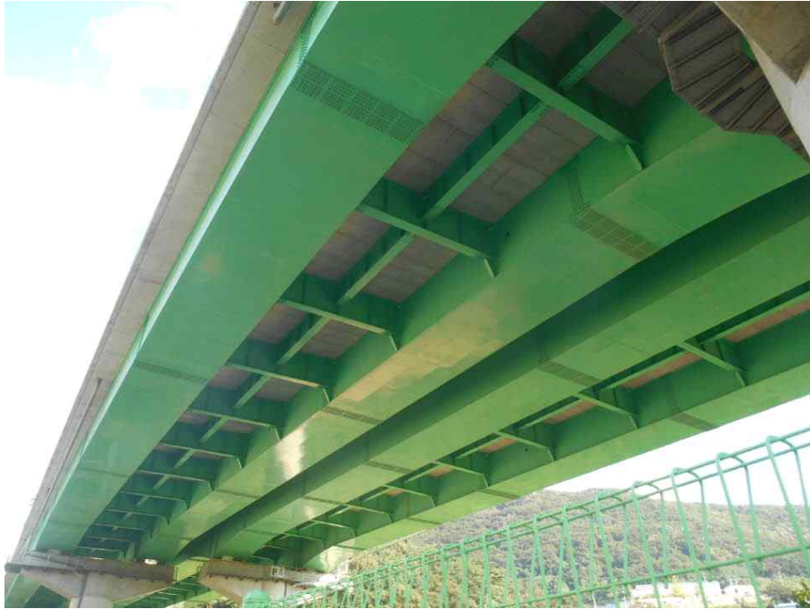
Steel Box Girder 외부 전경
