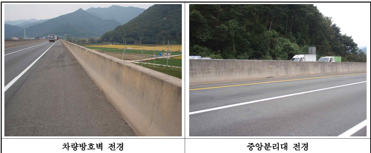
【사진 3.3.21】 방호벽 및 중앙분리대 전경(부산)
