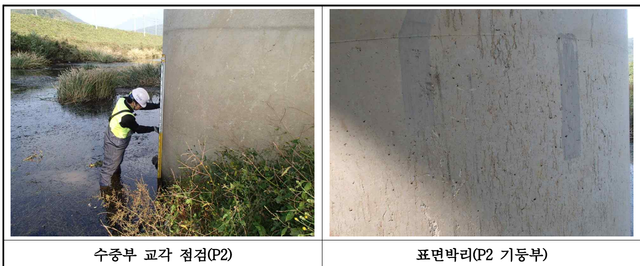
【사진 3.2.11】 교각 수중부 조사 현황(대구)
