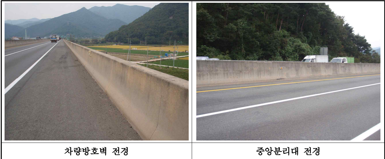
【사진 3.2.21】 방호벽 및 중앙분리대 전경(대구)
