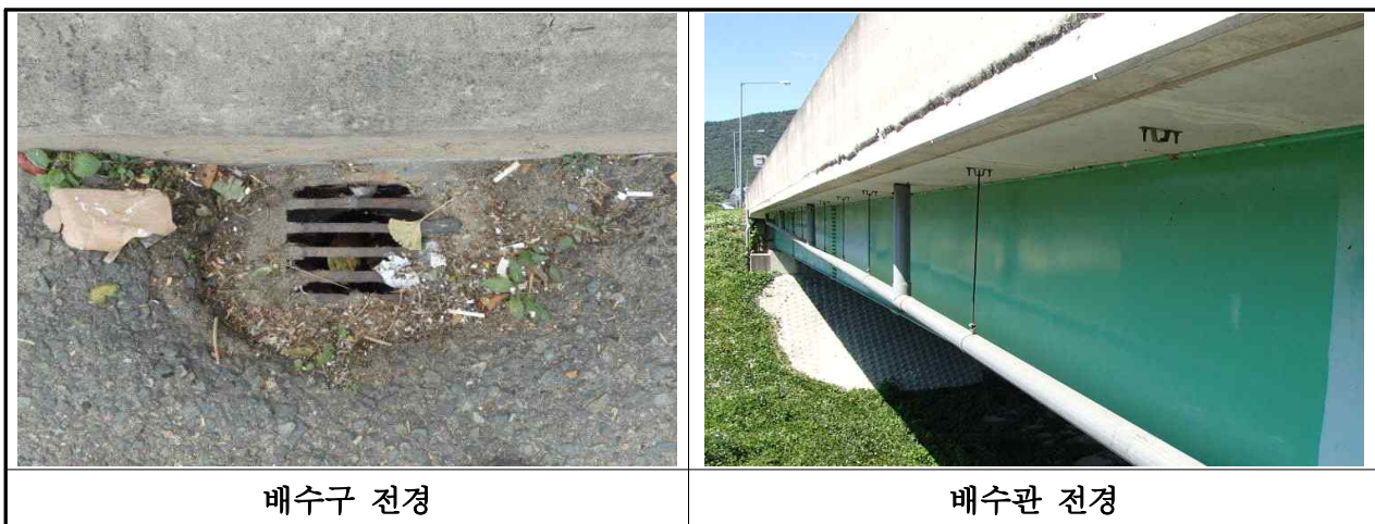
【사진 3.3.19】 배수구 및 배수관 전경(부산)
